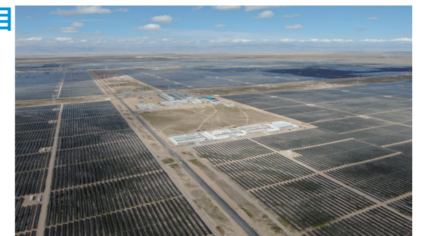
图24: 黄河水电青海特高压电站135MW项目
