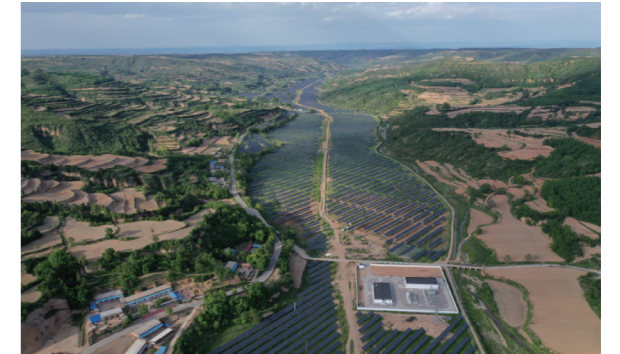
图22: 铜川250MW技术领跑者项目
