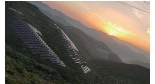
图23: 长治250MW技术领跑者项目
